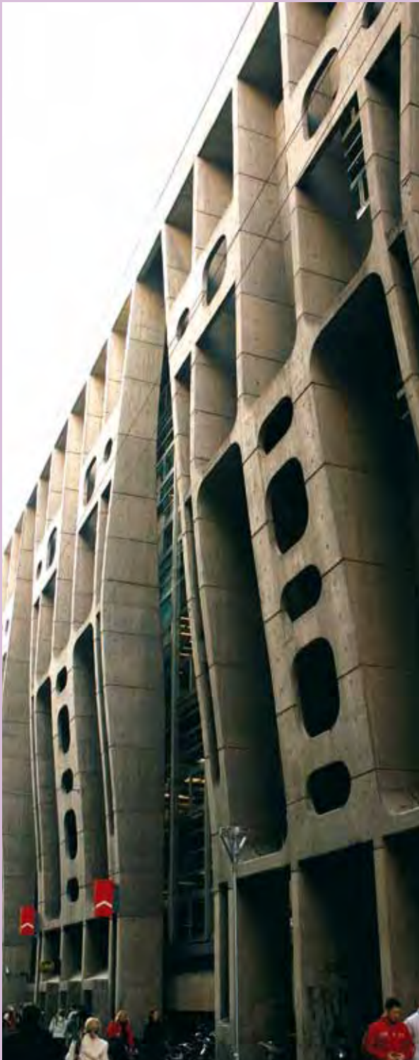
Edificio del Banco Hipotecario Nacional, proyecto de Clorindo Testa y Monumento Histórico Nacional, en la esquina de Reconquista y Bartolomé Mitre.
